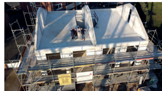
Die Eigentümer begutachten den Rohbau vor dem Errichten des Dachstuhl
