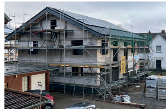
Der Rohbau ist fertiggestellt
