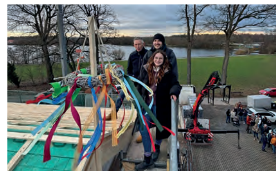
Richtfest mit Kranz
